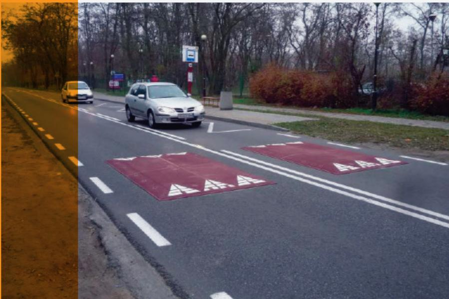
I dissuasori di velocità in gomma sono solitamente utilizzati nelle aree a 30 km/h. Hanno lo scopo di rallentare la velocità di transito delle auto e dei veicoli di emergenza, senza limitare autobus, veicoli a due ruote.
