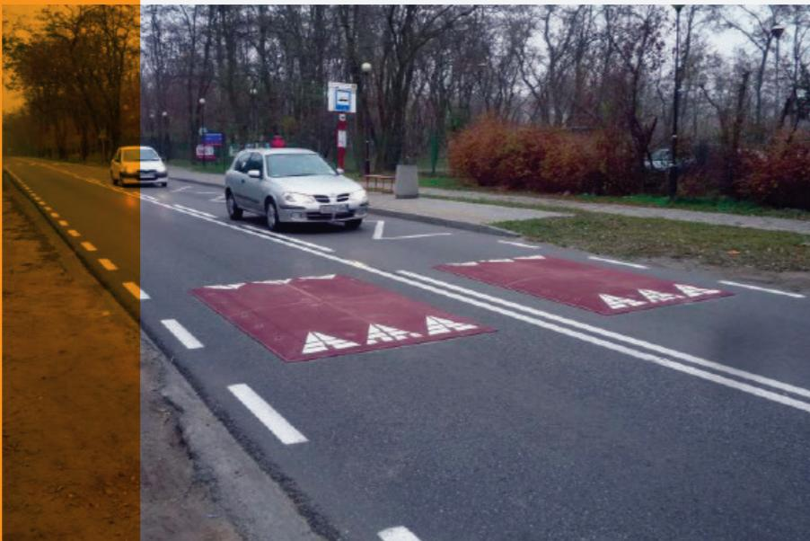
I dissuasori di velocità in gomma sono solitamente utilizzati nelle aree a 30 km/h. Hanno lo scopo di rallentare la velocità di transito delle auto e delle auto, senza limitare autobus, veicoli di emergenza e veicoli a due ruote.
